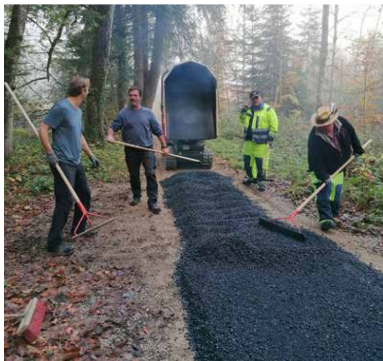
Das Steilstück beim Sophienweg wurde in Eigenregie durch den Bauhof neu asphaltiert.“
