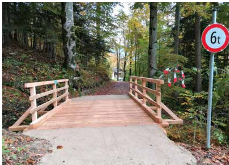
Die desolate Sensenbachbrücke an der Dr.-Ude-Promenade wurde von der Bauhofmannschaft komplett abgetragen und durch eine neue Brücke in Holzbauweise ersetzt.
