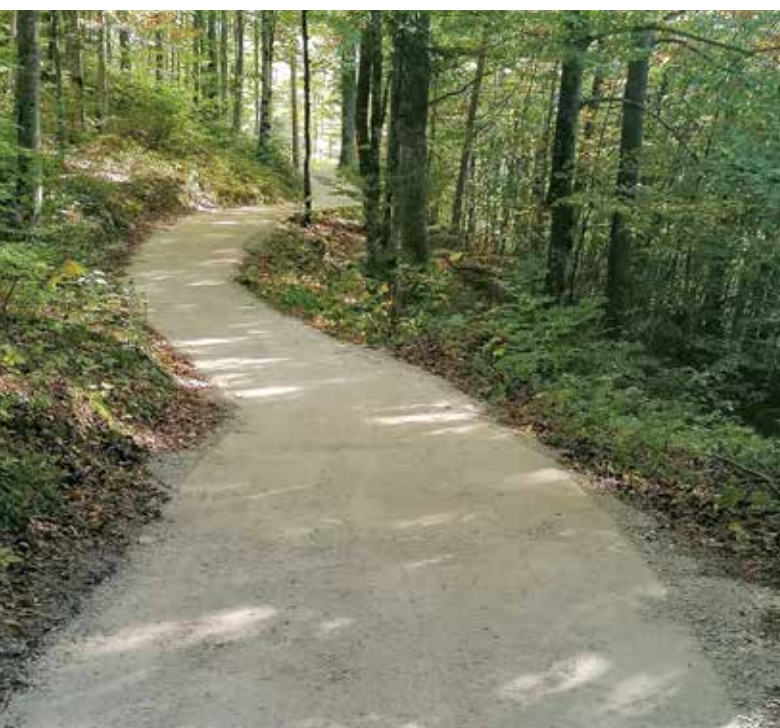
Auch der Wanderweg zwischen Rösslern und Gaiswinkl wurde saniert.
