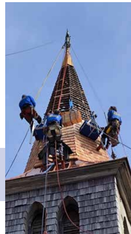
Der Turm der Grundlseer Kirche wurde mit Schindeln neu gedeckt.
