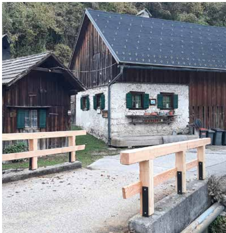
In Gößl wurde ein weiteres Brückengeländer erneuert.
