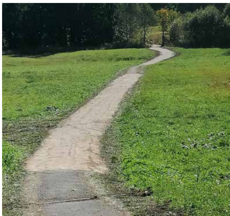
Beim Wanderweg über das „Arimoos“ in Mosern wurde eine neue Drainage errichtet und neu geschottert.
